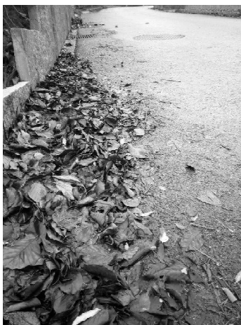
Beispiel: Schacht Ueligasse am 2. Dezember 2021 / Peter Hofer
